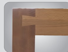
Schwalbenschwanzverzinkung in Hinterzange und Beiladerücken
